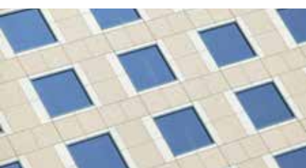
POKLÁDKA KERAMICKÝCH OBKLADŮ NA FASÁDÁCH
